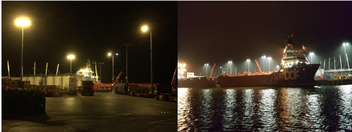
Figuur 3 De linker afbeelding toont de conventionele verlichting, de rechter afbeelding toont energiezuinige, slim aangestuurde, ledverlichting.
